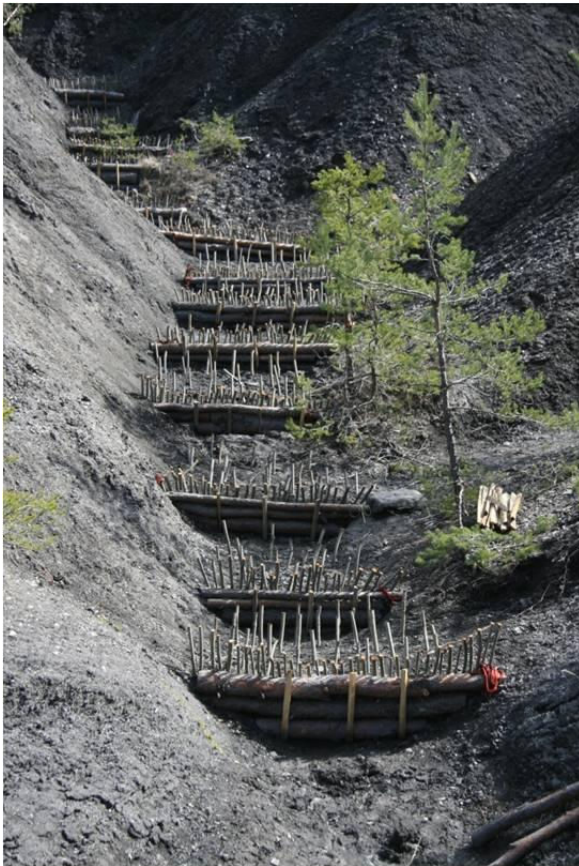
Figure 24 - Série d'ouvrages de génie écologique dans le lit d'une ravine marneuse érodée. La photographie a été prise juste après la mise en place des ouvrages en 2008. Les boutures de saules implantées en amont des seuils en bois mort n'ont pas encore émis de rejets. Source: Freddy Rey
