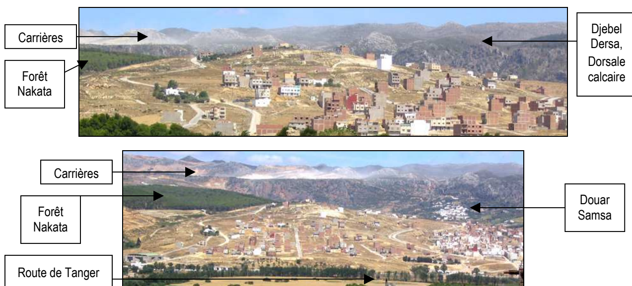
Photographies 6. Vues du lotissement de Prévention (Tétouan, 2003)
