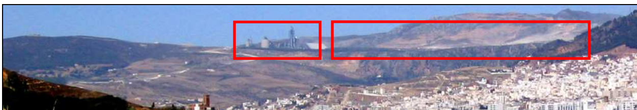
Le complexe industriel Lafarge avec, à l'est, la vaste zone des carrières puis la ville
