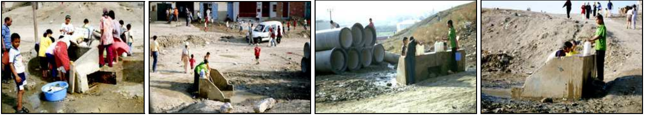
Les bornes-fontaines de Moghgha présentent des fuites et des aménagements sommaires, donc des contraintes pour les usagers (flaques d'eau, boue).
