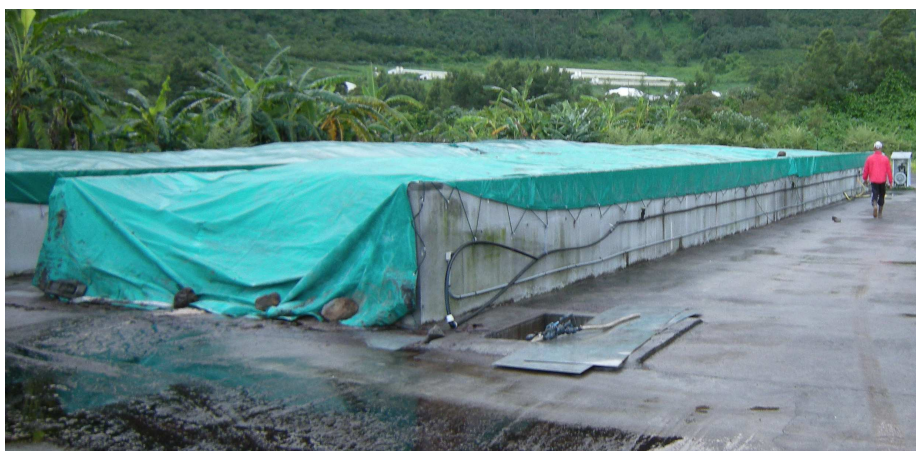
Figure 21. Silos de compostage Val'id® de Couvée d'Or
