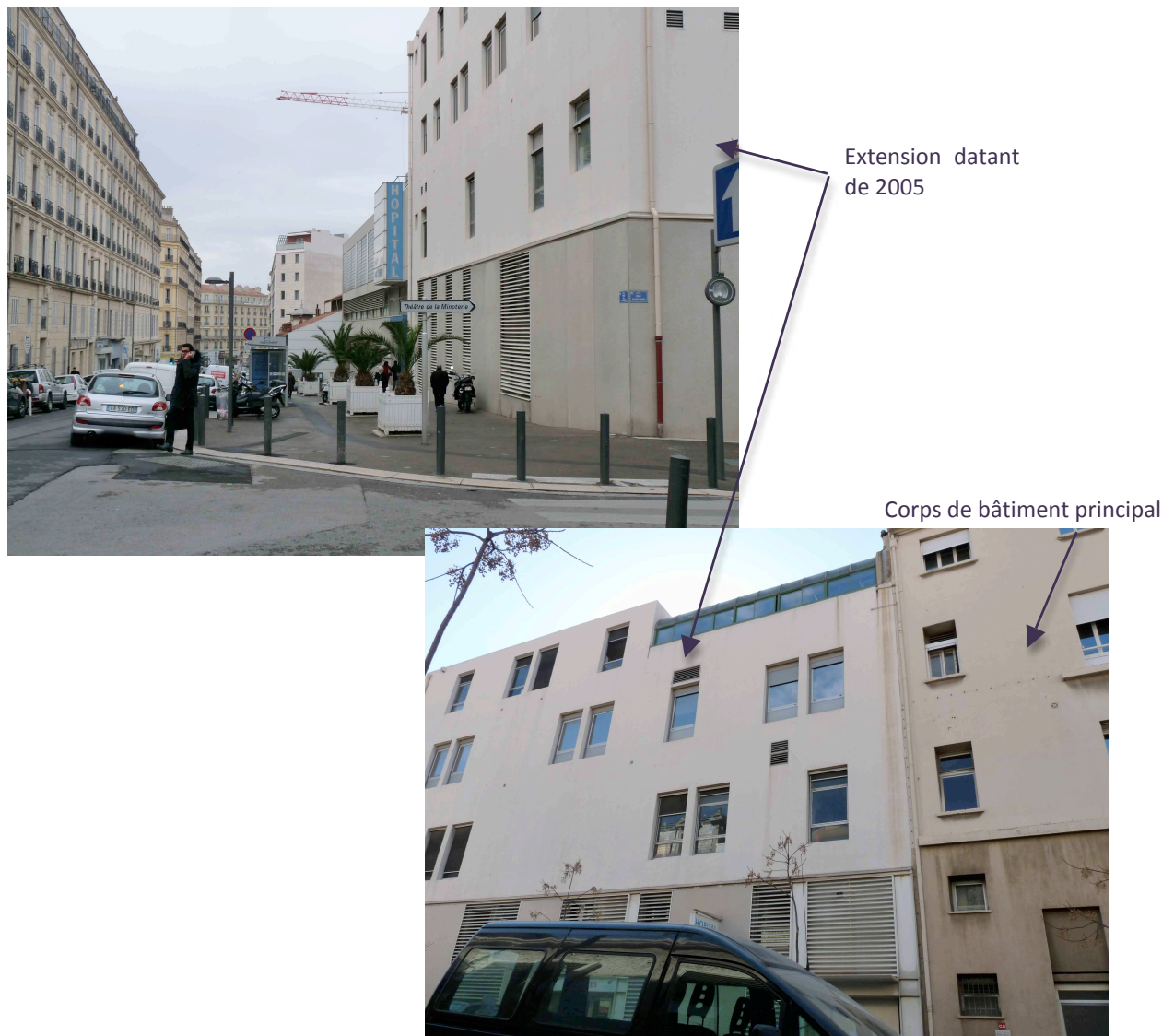
Figure 64 Différentes parties de l'hôpital Desbief
