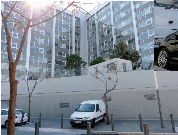
Corps du bâtiment vu depuis le trottoir opposé, rue d'Hozier
