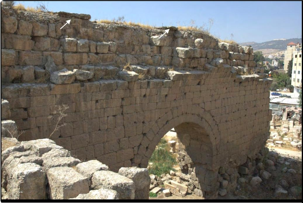
Figure 148 : rein occidental de la voûte de la salle A et indication de la mosaïque de couverture (T. Lepaon – 2009).
