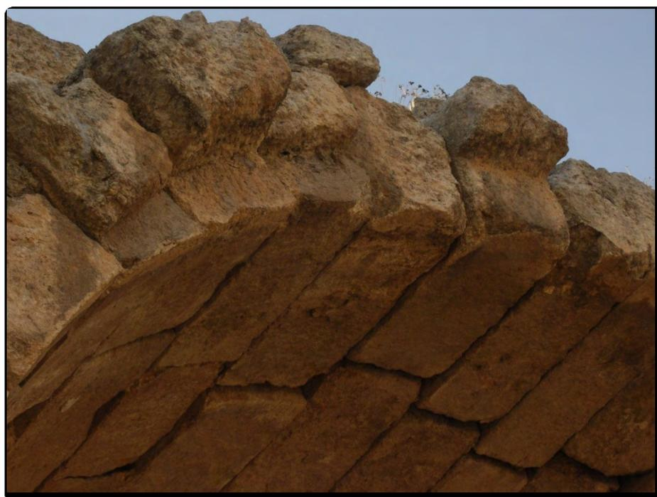
Figure 53 : partie supérieure des claveaux de la voûte 006 en saillie
