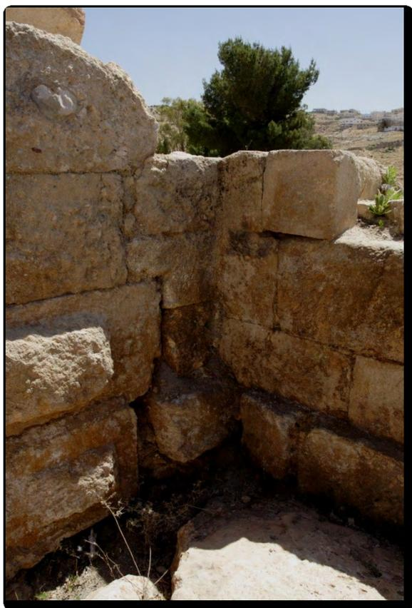
Figure 231 : reprise de fondations à l'angle sud-est de la salle E (T. Lepaon – 2007).
