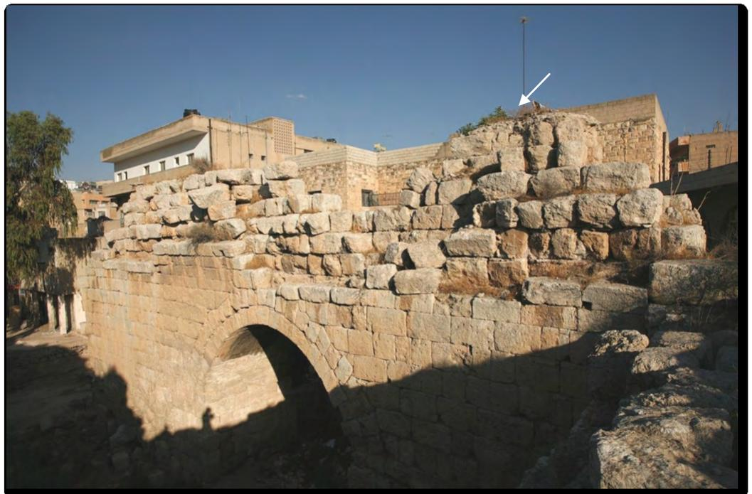
Figure 149 : rein oriental de la voûte de la salle A et indication de la couverture mosaïquée (T. Lepaon – 2009).
