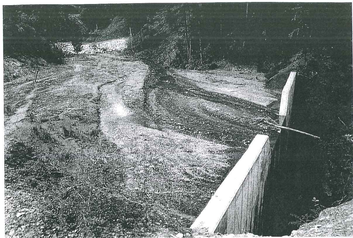
Planche 4 : Plages de dépôts en arrière des seuils aménagés par les services de la Restauration des terrains en Montagne (ONF, Sisteron).
