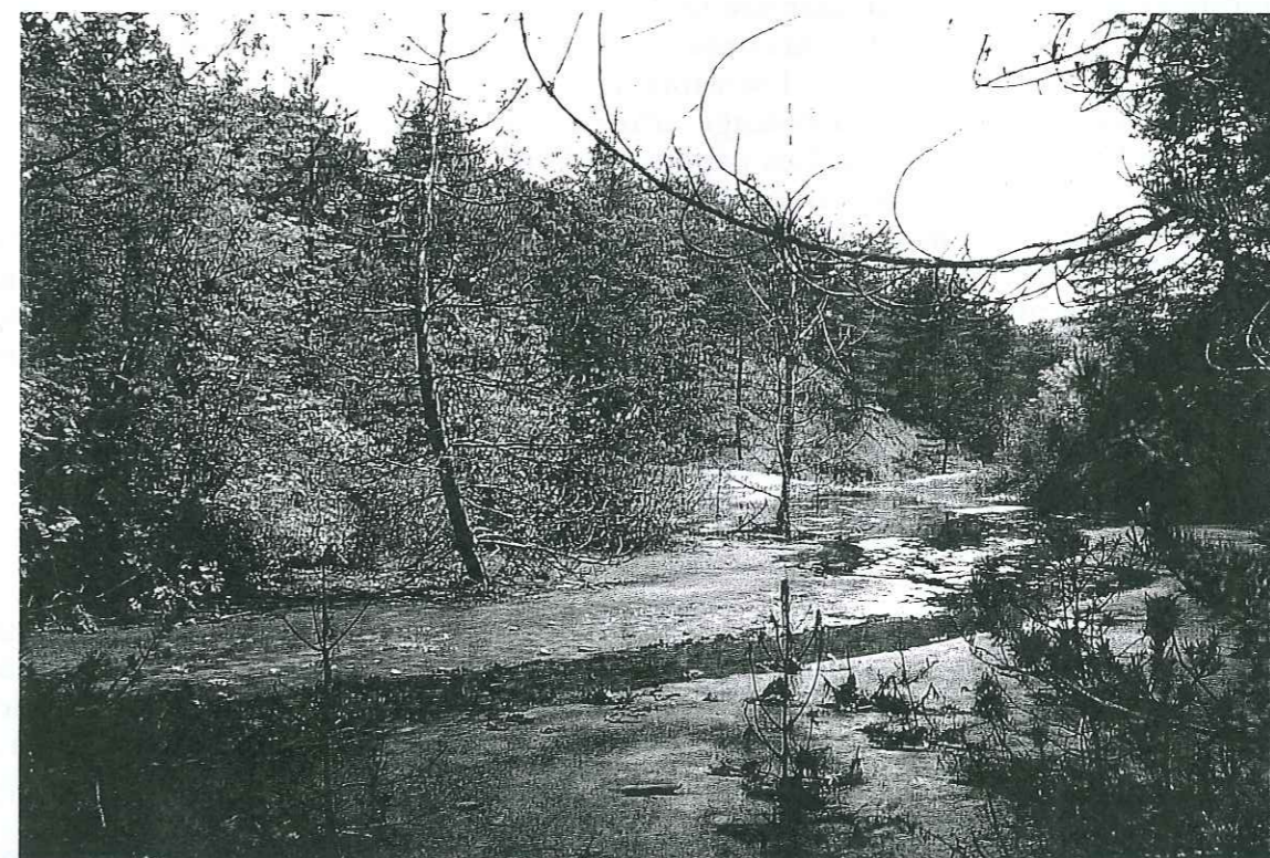
2. Plage de dépôts en arrière d'un ouvrage RTM dans le bassin du Saignon. Remarquons les pins noirs desséchés au deuxième plan.
