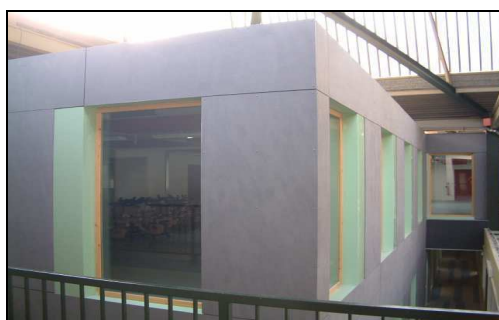
Figure 25. Un aperçu du bâtiment PREDIS
