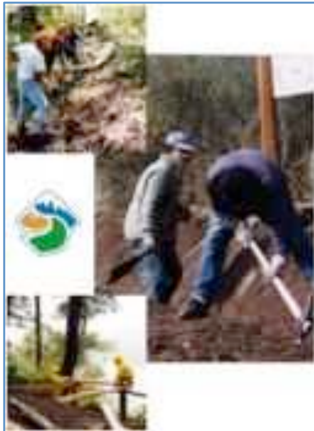
Illustration 13 : Construction du Sendero de Chile (Source : documentation personnelle)
