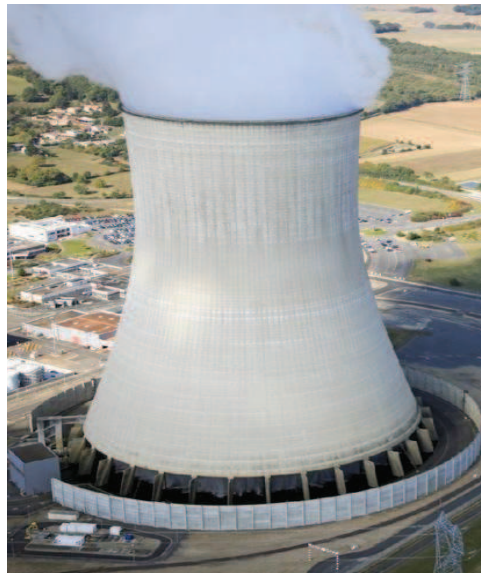
Figure 0.1 : Aéroréfrigérant de la centrale nucléaire de Civaux ( www.edf.com ).
