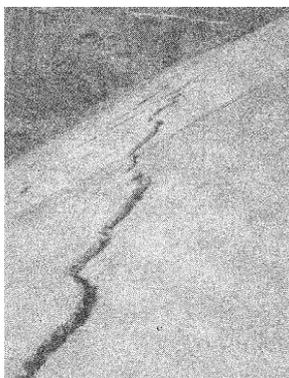
**Figure 1.24 : Fissures sur la couche d'appui (2B) [Cao & Zhang, 2001]**
