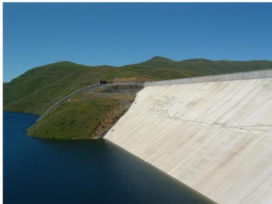
**Figure 4.39 : Fissures horizontales sur le masque amont à l'élévation 2040
