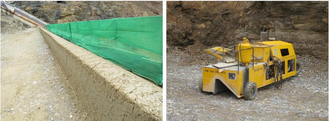
**Figure 1.21 : Béton extrudé (bordure profilée) réalisé pour le barrage de Puxiqiao (Chine, 2012) ;
