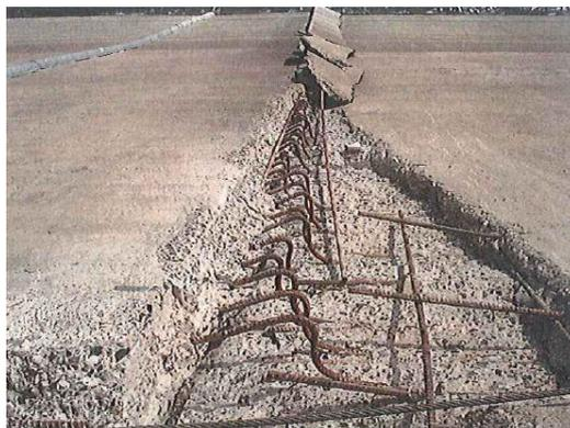
**Figure 4.40 : Fissures (le long des joints verticaux) [Pinto, 2008]**
