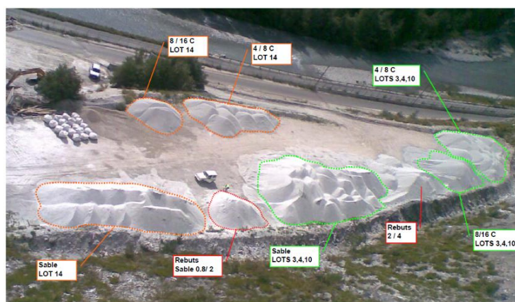
Figure 4 : Zone de stockage des granulats de la descenderie de Villarodin-Bourget/Modane
