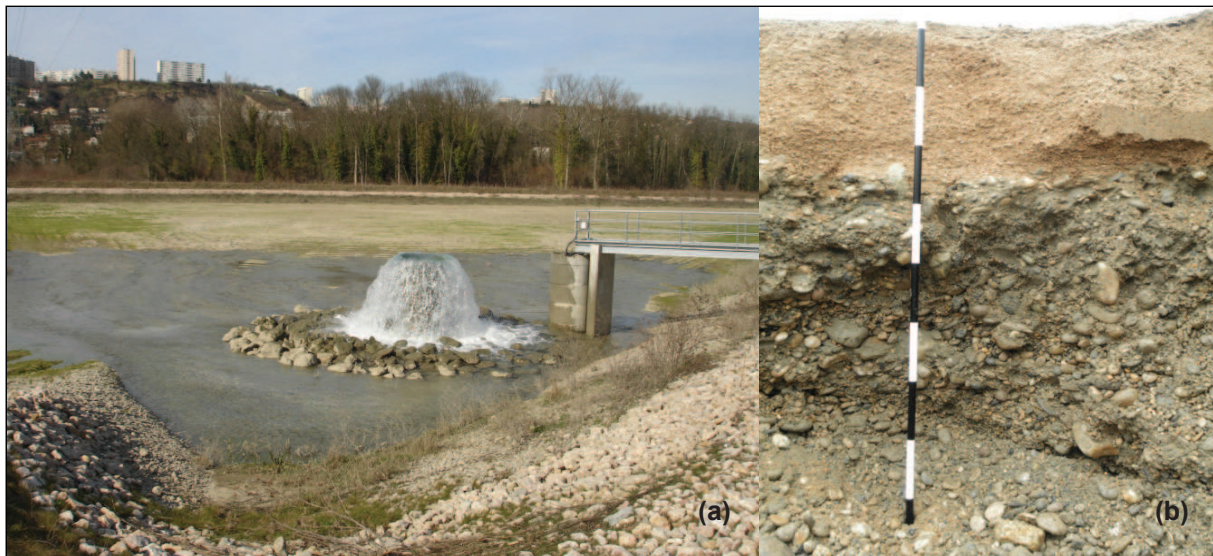
Figure 16 : Vue du remplissage d'un bassin d'infiltration (a) et d'une tranchée dans le fond d'un bassin d'infiltration (b)
