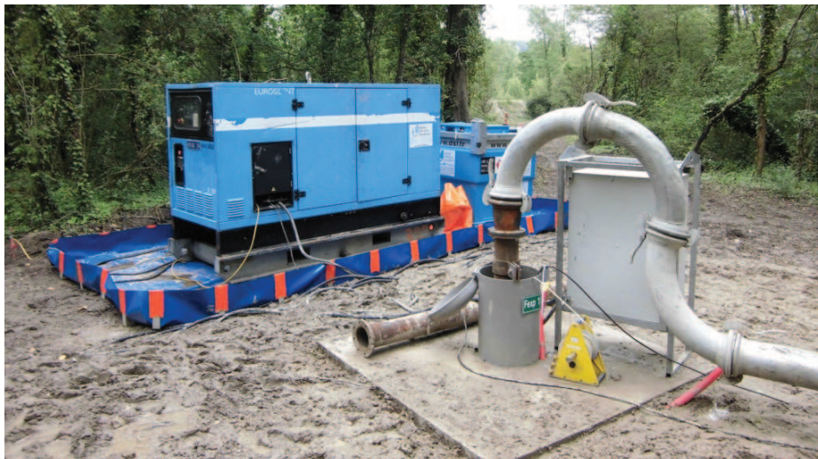
Figure 58 : Vue du dispositif d'essai de pompage dans Fexp1 sur le terrain
