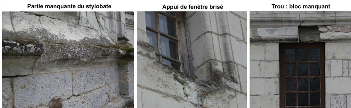
FIGURE 51 : EXEMPLES DE PARTIES MANQUANTES ET CASSURES
