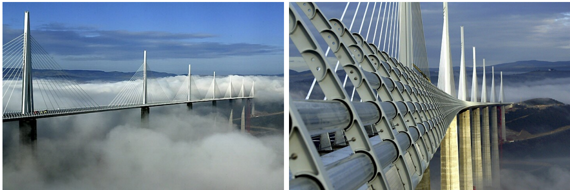
FIGURE 2.42 – Photographie du viaduc de Millau.
