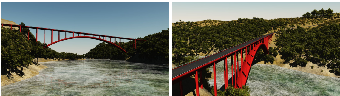
FIGURE 2.39 – Franchissement d'un canyon à l'aide d'un pont Eiffel.
