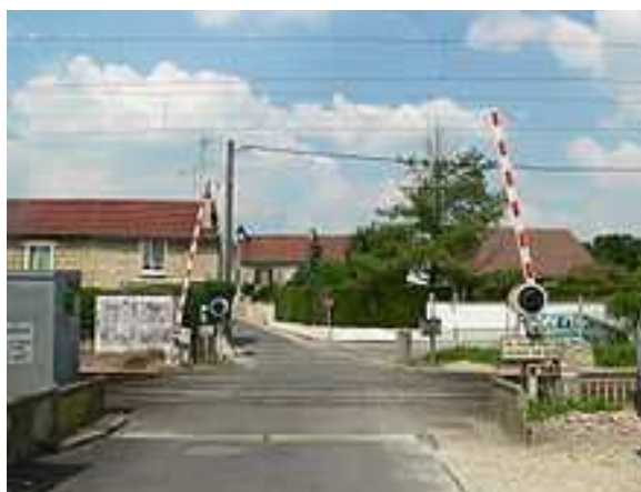
Photo. 2 Passage à Niveau gardé
