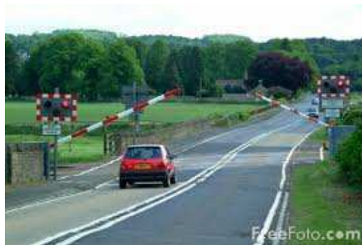
Photo. 2 Passage à Niveau automatique à demi-barrières (AHB)
