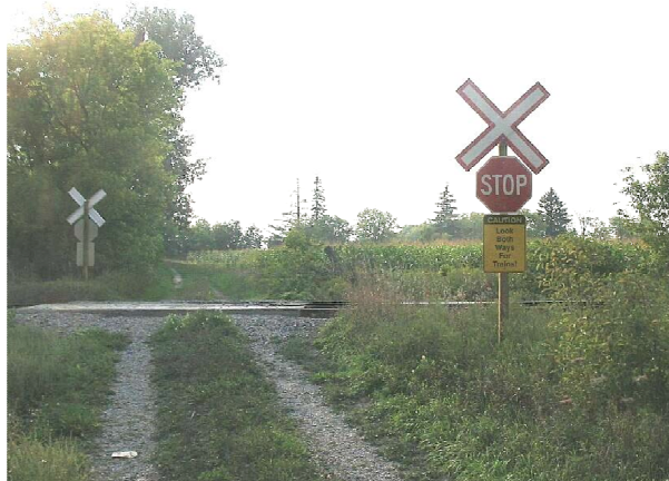
Photo. 4 Passage à Niveau mal conçu
