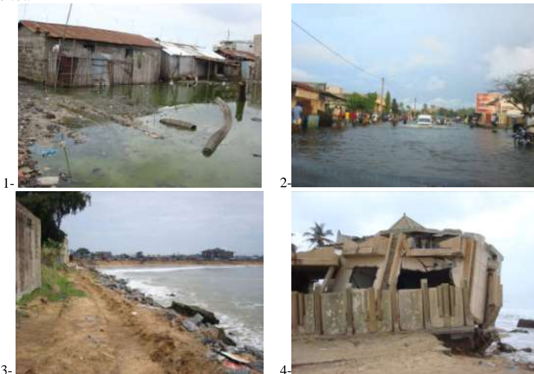
1- Sols détrempées (quartier Sègbèya-nord - Cotonou – 2010). 2- Inondation des rues (quartier Fidjrossè-centre - Cotonou – 2010). 3- Avancée de la ligne de rivage (quartier Donatin - Cotonou – 2010). 4- Abandon et effondrement d'habitation liés à l'érosion côtière (quartier Tokplégbé - Cotonou – 2010). (Clichés Charles-Dominé J.)
