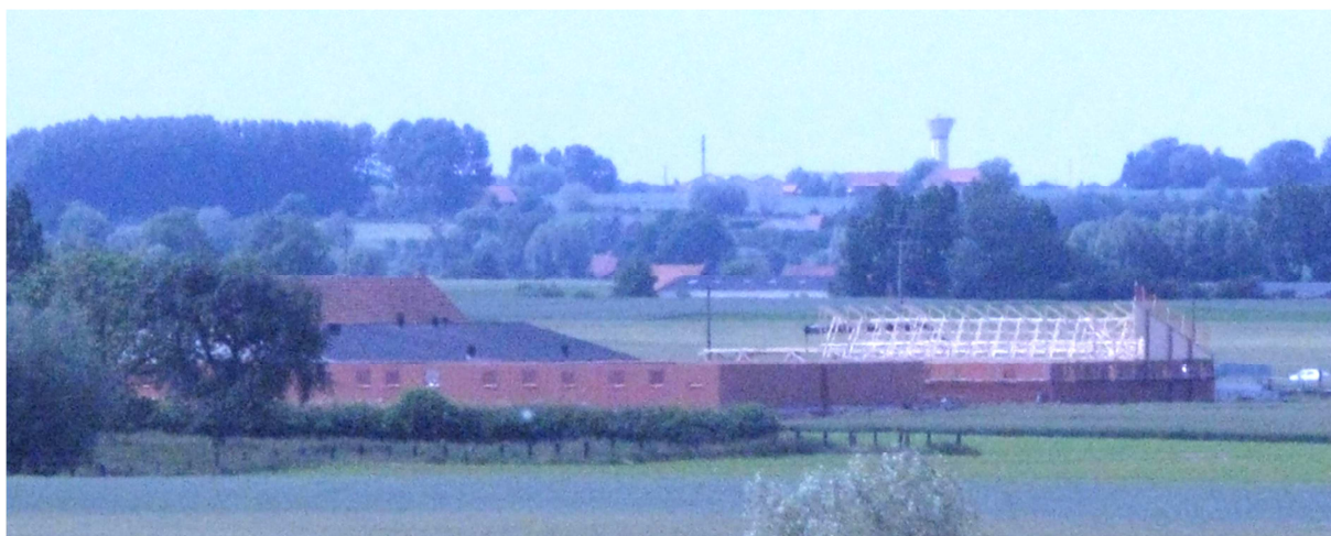
Photo 25. Porcherie en construction et aménagement paysager (Merris, 23 juin 2010)
