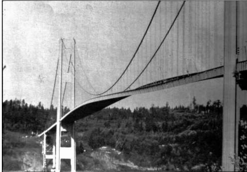
Figure 1.1 : Pont de Tacoma sous l'effet du vent, État de Washington (USA), 1940.
