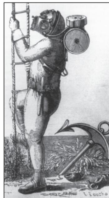
**Image n°2** : Plongeur équipé de l'équipement autonome Rouquayrol-Denayrouze, 1865.
