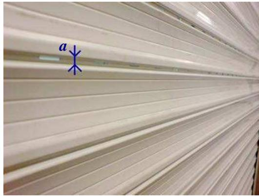
**Figure II-5 : Jeux inter-lames avec fentes (« ajours »), ouverts dans la partie suspendue du tablier**
