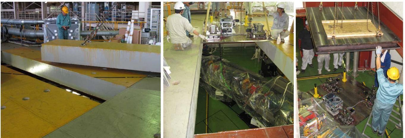
FIGURE 4.4 – Retrait d’une dalle et début de la descente du matériel de notre expérience dans le tunnel de l’anneau de stockage de l’ATF.
