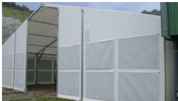
Figure 49. (g.) Exemple de structure démontable pour traitement des odeurs par photocatalyse 95 .
