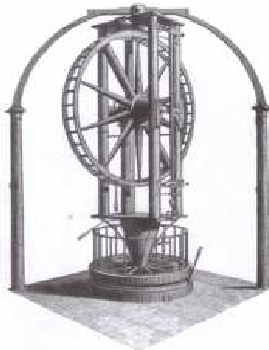
FIG. 1.5: Cercle de Ramsdem utilisé par Piazzini pour la mise à jour du catalogue d'étoiles, le jour où il découvrit Cérés. Sur ce schéma, deux des quatre arches ne sont pas représentées pour des raisons de clarté [Hoskin, 1995] (image libre de droit).
