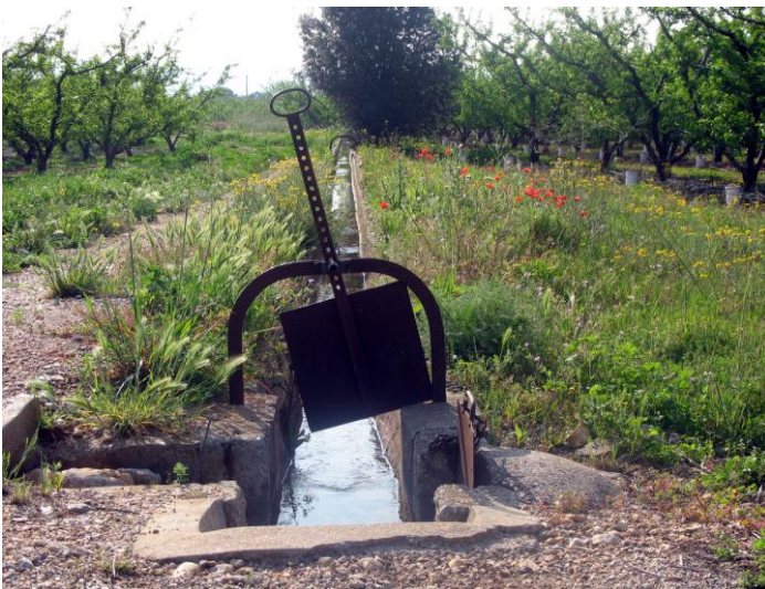
Photo 10 : Réseau d'irrigation, St-Jean-de-Fos © ARH 2007
