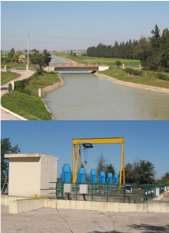
Photos 5 et 6 : Equipements hydrauliques dans la plaine du Gharb © ARH 2005
