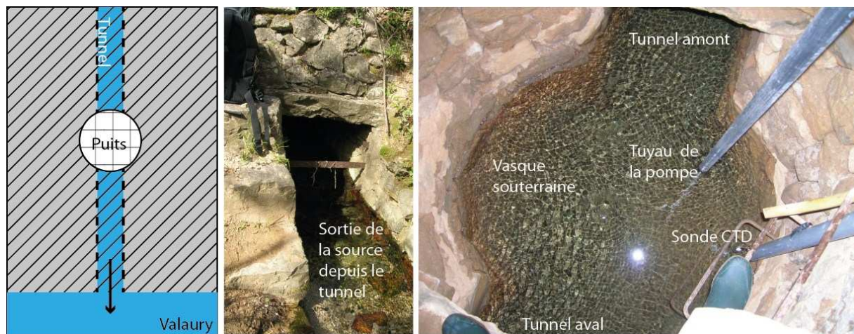
Figure 2.7 : Lieu d'équipement de la source Werotte, avec une vue de la sortie de la source dans le Valaury et une vue de la salle souterraine où est installée la sonde.
