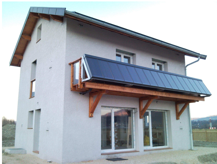
FIGURE 4.1 – Maison INCAS de l'INES à Chambéry
