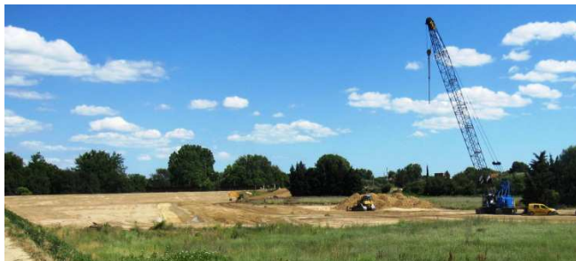
Photo 7.14 : Travaux sur la digue (photo : C. Clément juin 2012)
