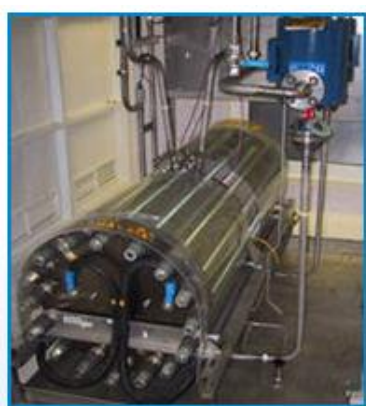
Figure IV-1 : Station de production d'hydrogène dans le projet ALTHYTUDE (ALternative Hydrogène dans les Transports Urbains à Dunkerque).
