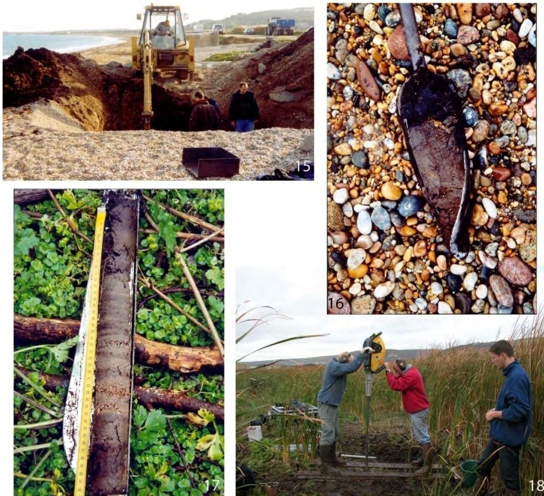
Photo 15 - Sondage à la pelle mécanique effectué sur l'estran de l'Anse Saint-Martin Photo 16 - Sondage à la tarière effectué sur le cordon de galet de l'Anse Saint-Martin Photo 17 - Carottage à la sonde russe effectué dans la vallée du Grand Douet à Biville Photo 18 - Carottage au carottier à percussion effectué dans la Réserve Naturelle Nationale de la Mare de Vauville à La Hague (Clichés L. Lespez)
