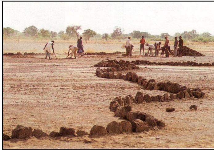
Photo 178 : page 239. Des diguettes contre l'érosion des sols au Burkina Faso.
