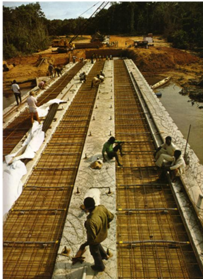
Photo 139 : 5n80, p171. Construction d'un pont sur le Komo dans la forêt gabonaise. Pavard
