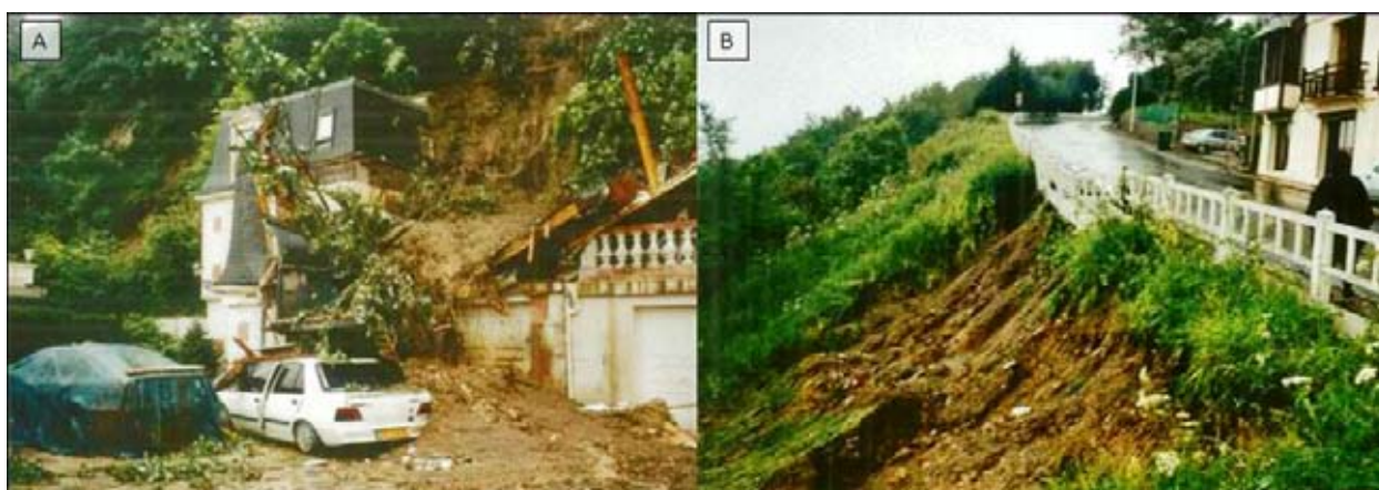
Figure 1-5. Glissements de terrain sur la commune de Trouville-sur-Mer déclenchés suite aux orages du 1 er juin 2003 (source : Lebret, 2003). (A) Glissement au lieu-dit "Les Creuniers", en amont du glissement de Hennequeville, (B) Glissement superficiel déclenché à l'est du glissement du Chant des Oiseaux.
