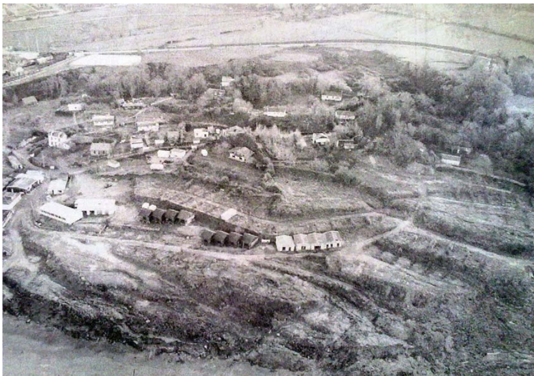
Figure 2-20. Vue aérienne du quartier des Graves montrant les principaux aménagements endommagés ou détruits. Le camping est situé au premier plan (extrait du journal Ouest-France paru en janvier 1982).
