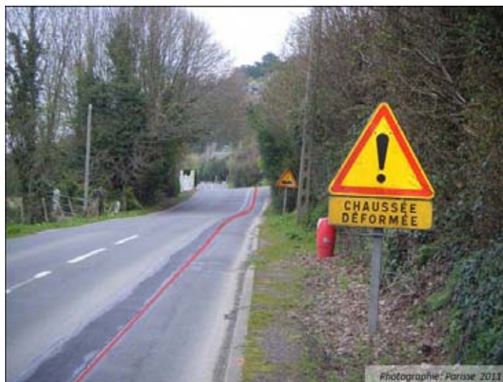
Figure 9-3. Route départementale 513 déformée par les mouvements 'permanents' à Hennequeville.
