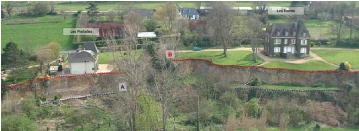
Figure 2-26. Positions de l’escarpement principal en 1995 (A) et 2001 (B) au droit des propriétés les Préfailles et les Ecores au glissement des Fosses du Macre à Cricqueboeuf (Photo : DREAL Basse-Normandie, avril 2001).
