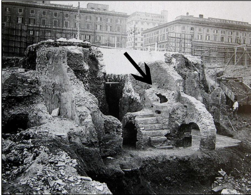
Figure 29 : Traces de chaudière située à l'arrière du caldarium des thermes de la piazza del Cinquecento, regio V, Rome (d'après Barbera 1996)
