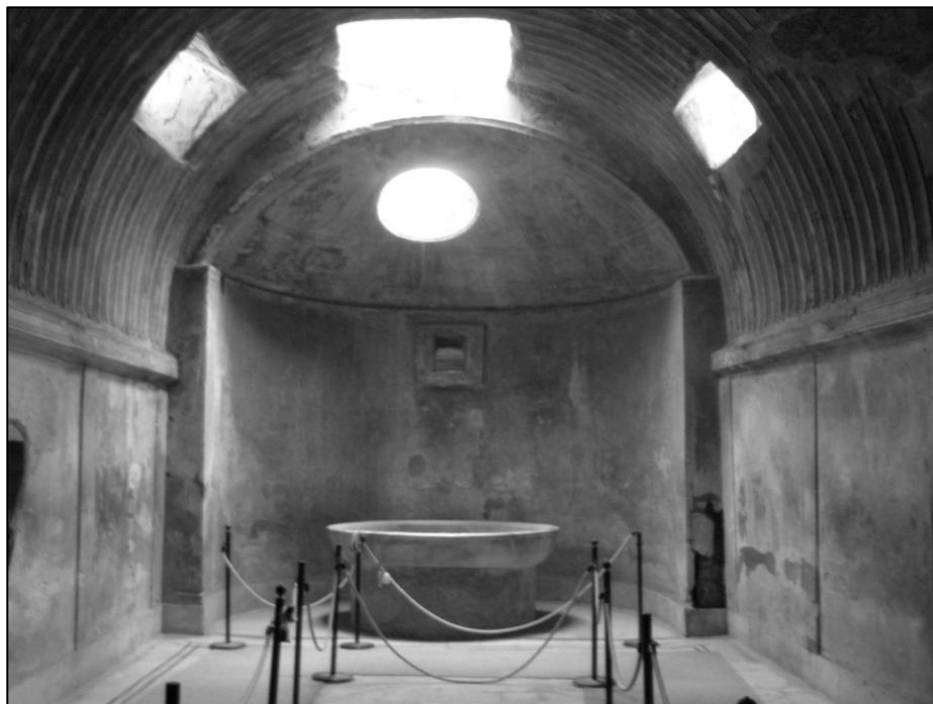
Figure 51 : Schola labri du caldarium des thermes du Forum de Pompéi, percée d'un oculus , et abritant le labrum destiné aux ablutions (cliché A. L. Foulché).
