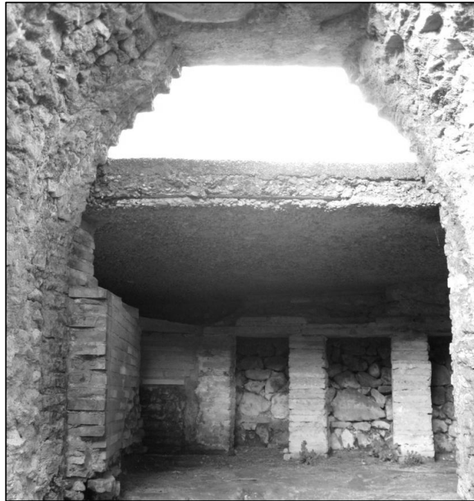
Figure 34 : Hypocauste du caldarium des thermes du Forum à Ostie, vu du praefurnium . Le système a atteint ici sa forme standard, à savoir un sol « suspendu » composé de plusieurs couches de mortier hydraulique, et soutenu par des colonnes de bessales (cliché A. L. Foulché).
