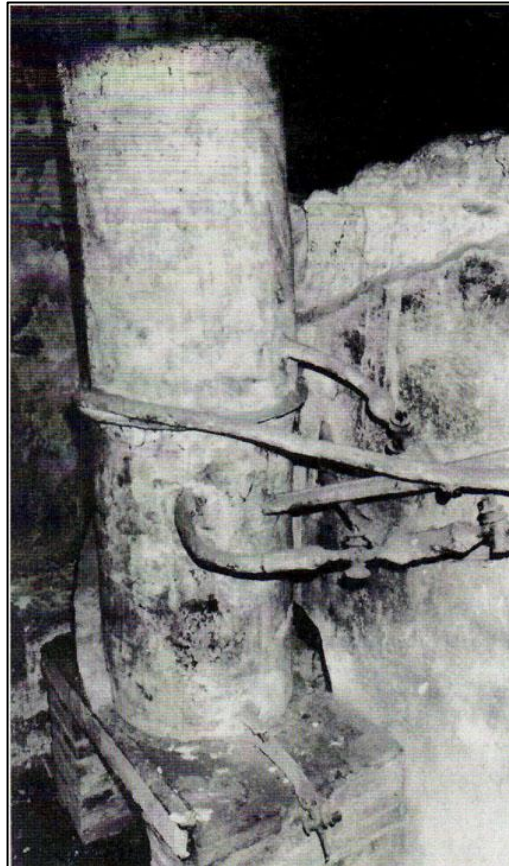
Figure 28 : Chaudière de la Villa della Pisanella, Boscoreale (Broise, 1987)
