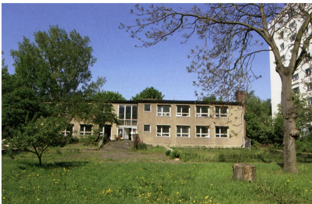
Pépinière d'entreprises à Friedrichsfelde
