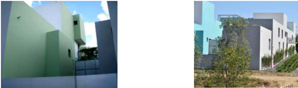
Figure II. 36 Deux images de l'îlot 2 du quartier de la Bottière montrant les couleurs des façades.
