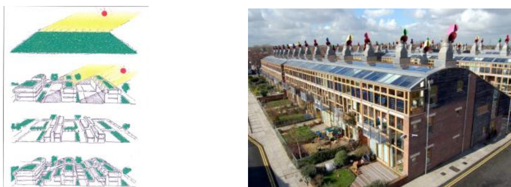
Figure II. 3 A gauche : Axe héliothermique comme élément fédérateur de l'organisation du quartier de Bedzed. A droite : utilisation des panneaux photovoltaïques pour la production d'énergie sur les toits des bâtiments du quartier Bedzed (source : internet )
