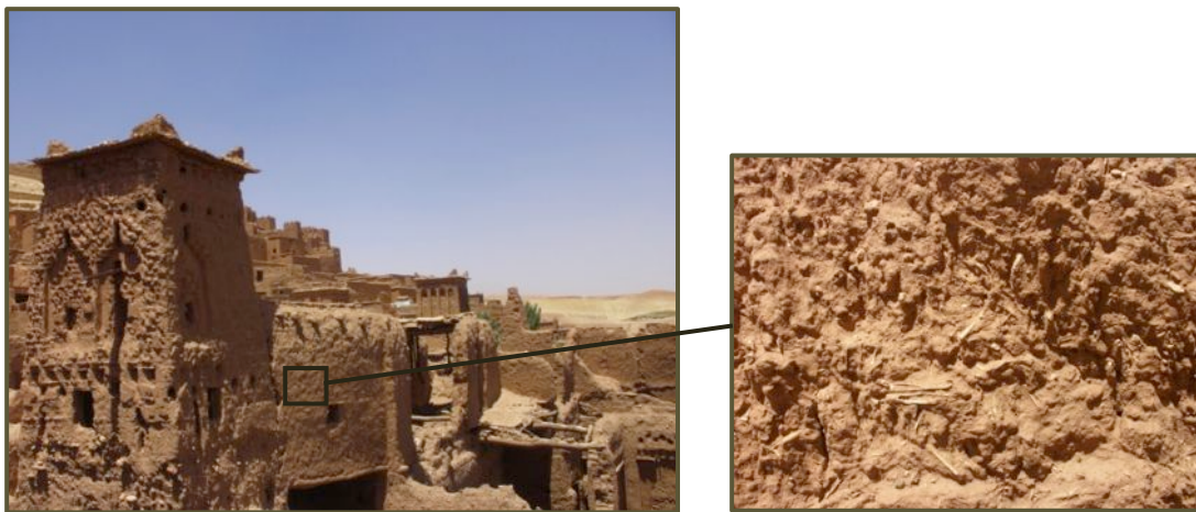
Figure I. 4. Ksar d'Aït Ben Haddou, Maroc, XIIIème siècle. Un ensemble constructif mêlant pierre, terre et végétaux lignocellulosiques.
