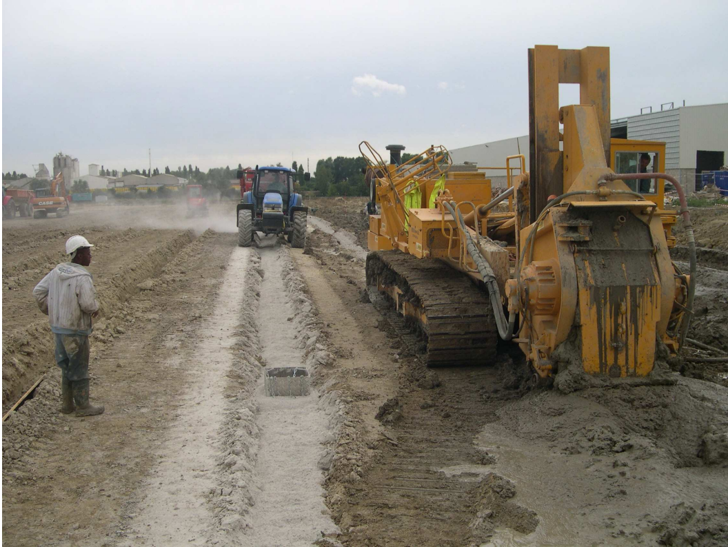
Figure 72 Epandeur en train d'épandre le ciment dans la prétranchée (à gauche) et trancheuse en action (à droite)
