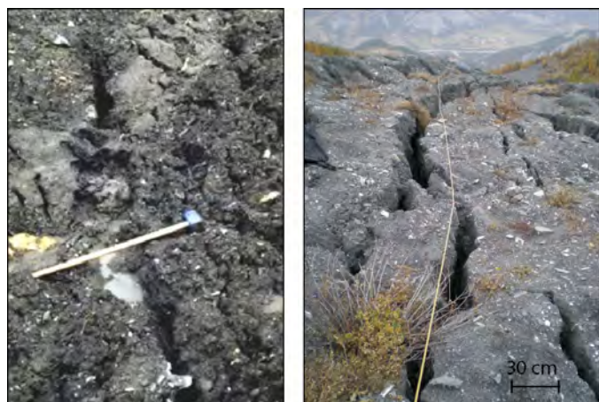
Figure 4.1 – Fissures partiellement saturées pendant un épisode pluvieux en juin 2002 (Malet, 2003) et fissures sèches en octobre 2008 sur le glissement-coulée de Super-Sauze.
