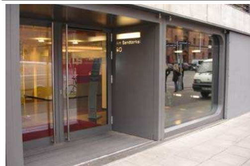
Photographie 3: Hamburg. Quartier HafenCity. Premier niveau étanche.
