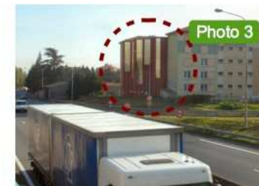
Protection anti-bruit en fermeture de façade
