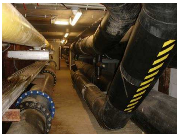
Photographie 4: Projet COST C19. Visite d'une galerie multi-fonctions à Amsterdam.
