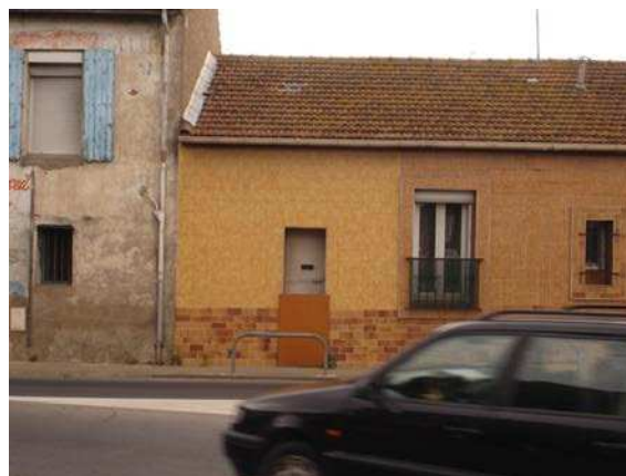
Photographie 5: Quartier du Faubourg. Maison équipée d'un batardeau.
