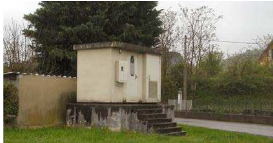
Photographie 11: Givors, cité du Garon. Ouvrage technique surélevé.
