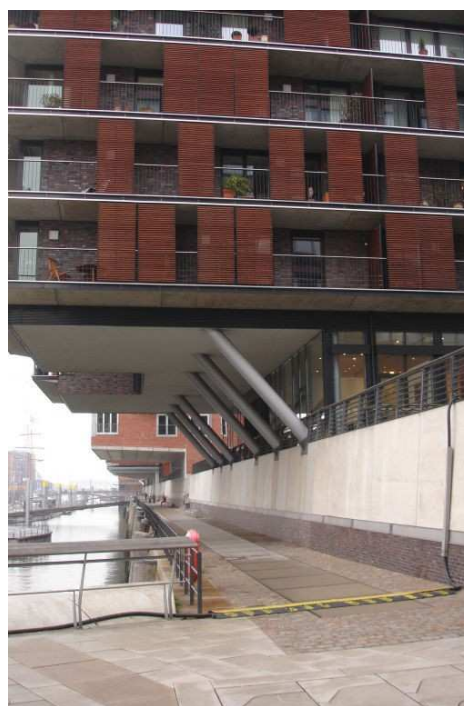
Photographie 2: Hamburg. Quartier HafenCity. Immeubles en console pour tenir compte des crues.
