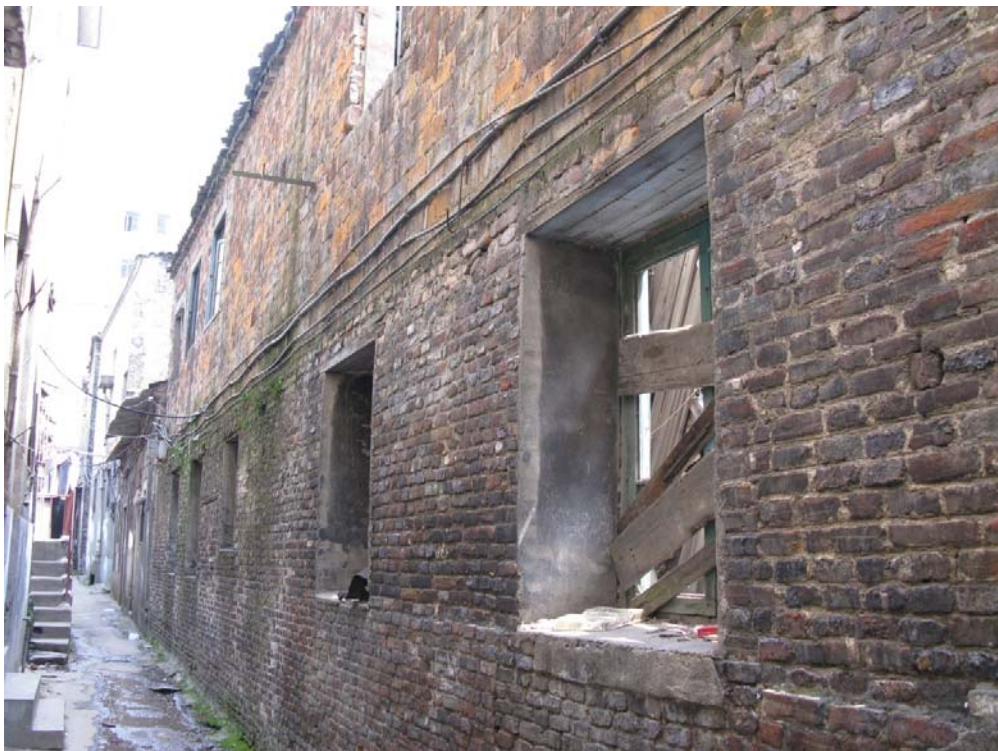
Figure 342 : Façade en briques d'un ancien atelier, Jingdezhen, 26 mars 2011. Photographie : N. Balard.
