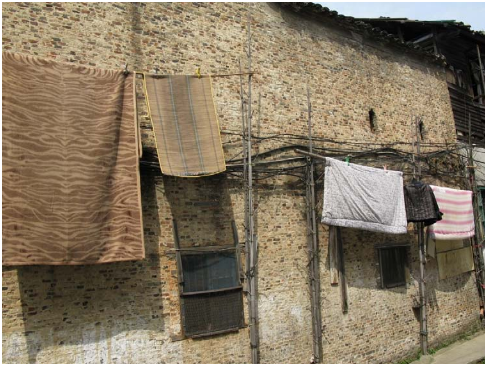
Figure 341 : Façade d'un ancien bâtiment construit à l'aide des briques usagées des fours, Jingdezhen, 26 mars 2011. Photographie : N. Balard.
