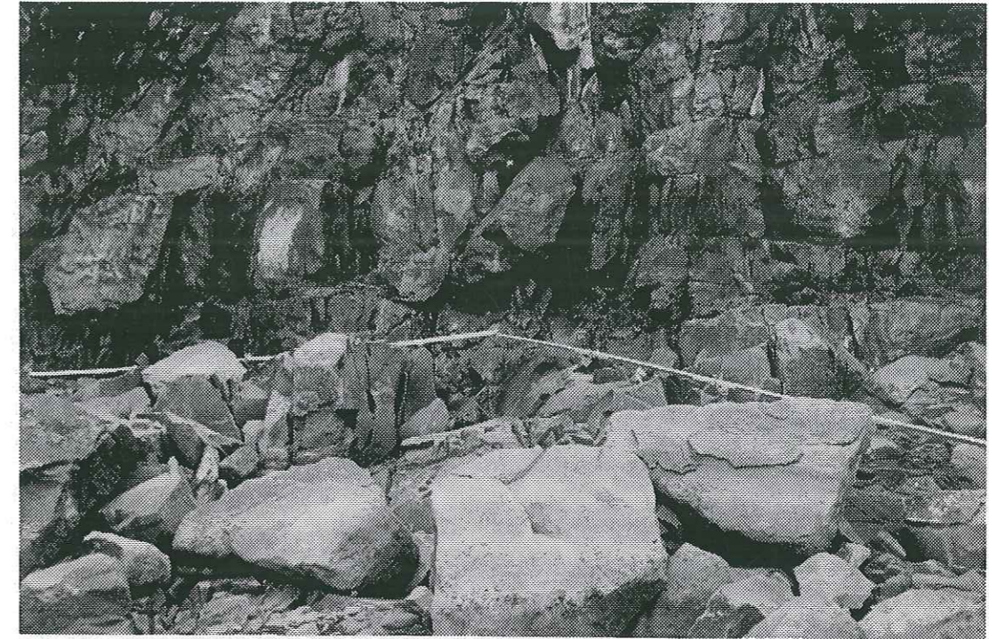
Fig. 137 - Disposition de la mire pour les relevés de fracturation le long de la paroi rocheuse (zone sud, site I).
