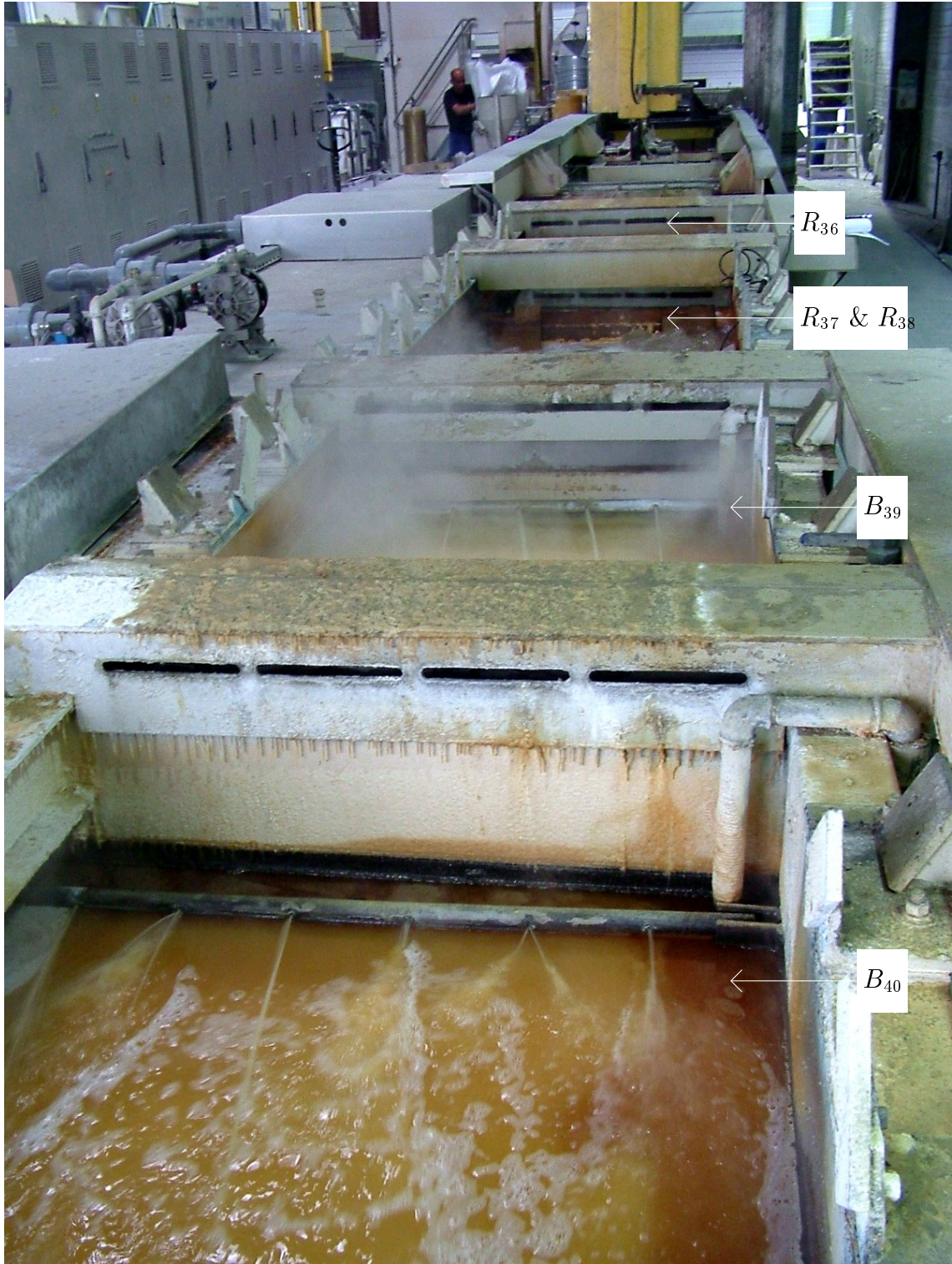
FIG. .2 – L'ensemble des "bains de dégraissage lessiviel alcalin" et des trois rinçages en cascade
