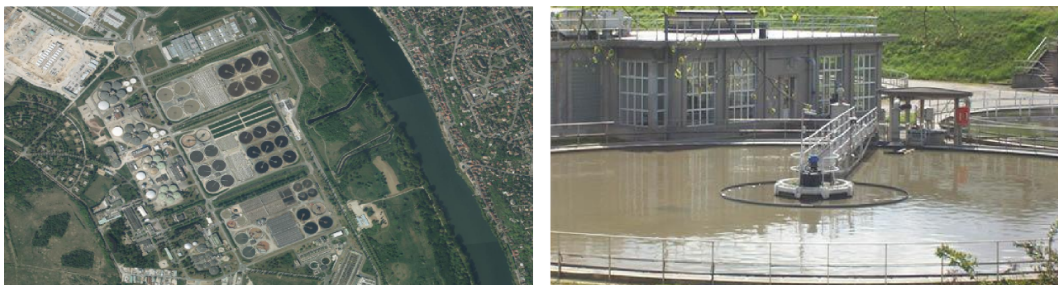
FIGURE 10 – De gauche à droite : Vue aérienne de la station d'épuration d'Achères près de la Seine, à 40 km en aval de Paris ( Photo aérienne, IGN 2011 ), bassin d'oxygénation de la station d'Achères favorisant la nitrification ( Cliché : SIAAP ).
