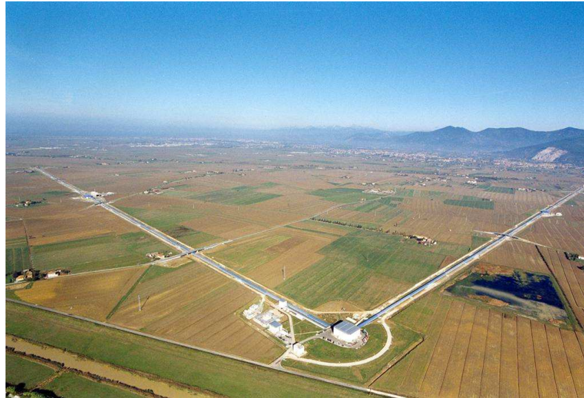
FIGURE 2.1 : Photographie aérienne de Virgo.
