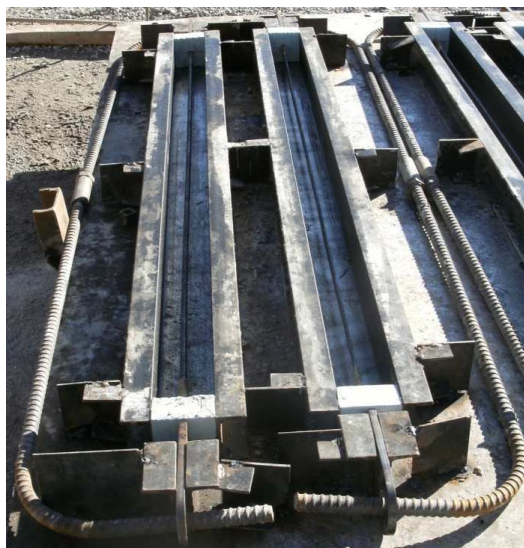
FIGURE 3.13 – Mise en place du coffrage du tirant
