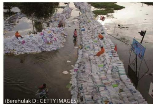
Fig. 8.9. Dispositifs de protection : batardeaux, sacs de sables.
