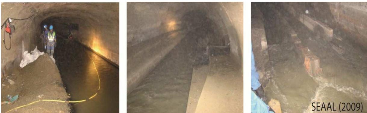
Fig. 7.13. Travaux de curages à l'intérieur du collecteur Oued M'Kacel.
