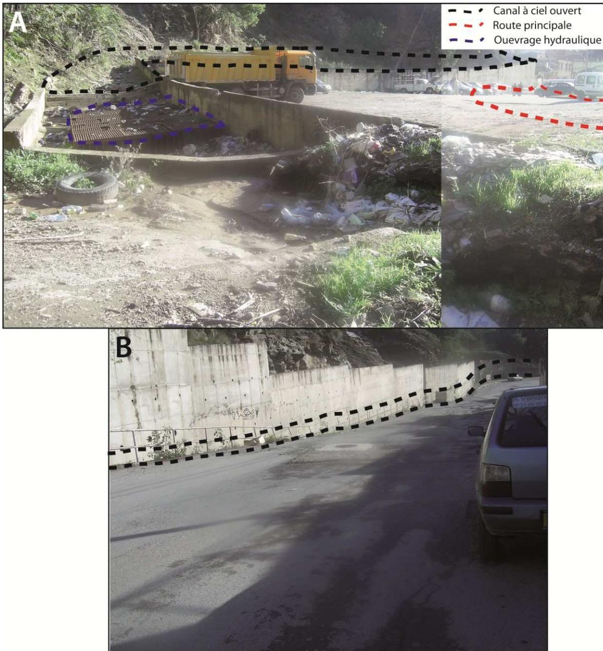
Fig. 7.10. Collecteur à ciel ouvert. A : en aval de l'ouvrage Jaubert ; B : le long de la route qui traverse le quartier ; C : Encombres et embâcles formés par différents matériaux.
