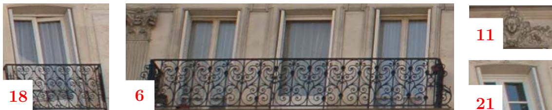
FIGURE 1.4 – Diversité des matériaux et des plans des baies : 18) Balustrade en fer forgé ; 6) Balcon filant du troisième étage ; 11) Agrafe au sommet du linteau ; 21) Meneaux séparant les vitres.
