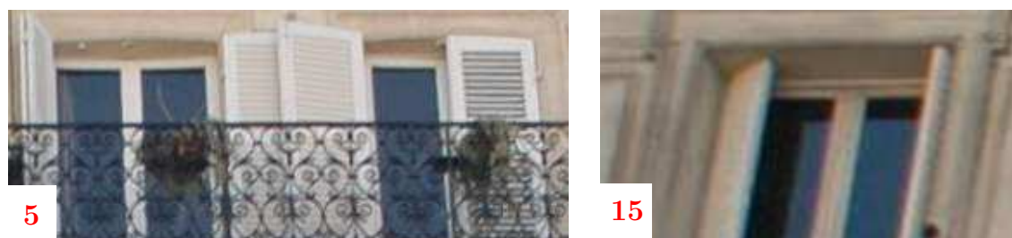
FIGURE 1.9 – Variations des contrevents : 5) Ouverture sur les trumeaux ; 15) Ouverture dans l’embrasure.
