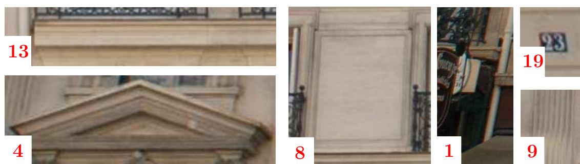
FIGURE 1.5 – Ornaments de la façade : 4) Fronton triangulaire au-dessus d'une fenêtre ; 13) Cordon sous le quatrième étage ; 8) Table sur un trumeau ; 19) Plaque du numéro de l'immeuble ; 1) Enseigne en fer forgé (tronquée par le bord de l'image) ; 9) Couche de pollution.
