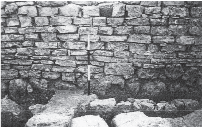
3. Ai , le mur occidental du bâtiment A composé de pierres taillées en forme de briques (Sala, 2007b, fig. 77)
