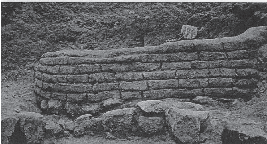
3. Jéricho , maçonneries en briques : mur de maison rectangulaire (haut) et circulaire (bas) (Garstang, 1936, pl. L)
