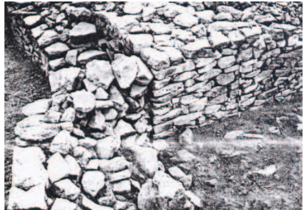
4. Leviah Enclosure , appareillage d'un mur en pierre sèche (Kochavi, 1993, p. 915)
