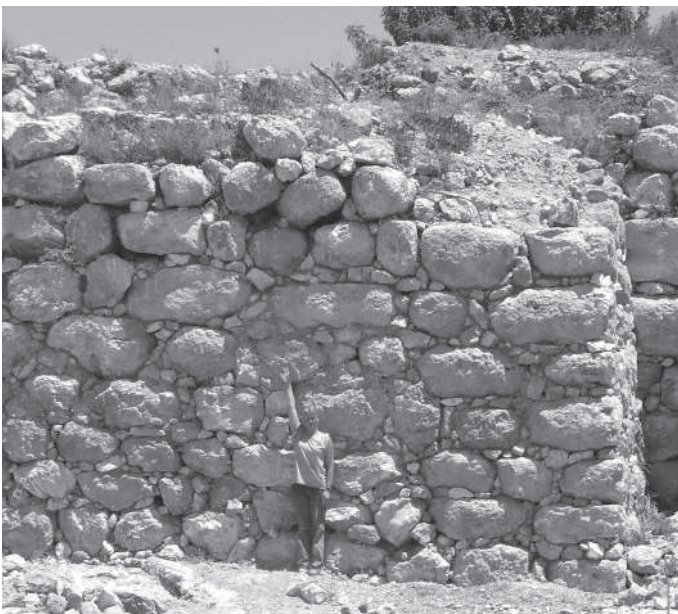
5. Tel Yarmouth , appareil cyclopéen du rempart (photo L. Poirier)
