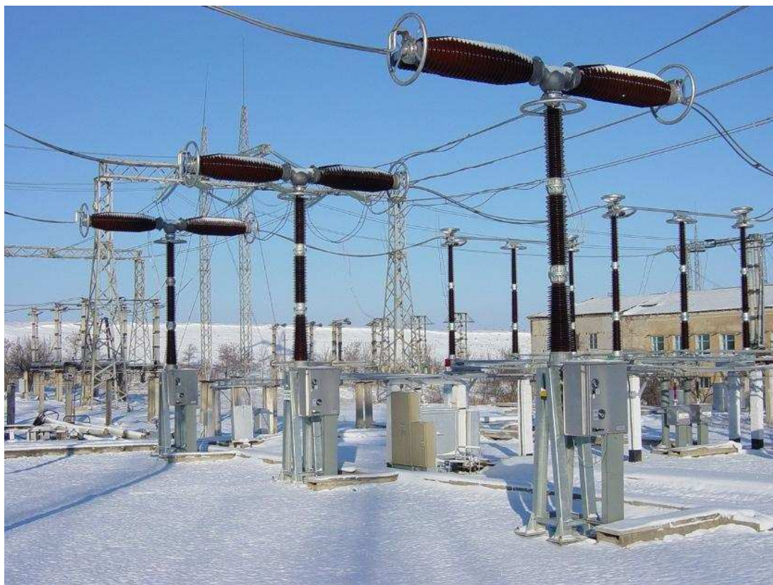
FIG. 1.1 Disjoncteur Alstom série GL300 de 245 à 800 kV
