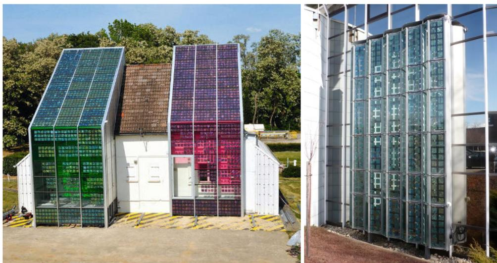
FIGURE 1.13 – Photos des deux prototypes de double-façades construits dans le cadre du projet RESSOURCES. À gauche, deux double-peaux façade et toiture installées sur la maison ETNA située sur le site EDF R&D des Renardières ; à droite, la double-façade de 7 m de haut par 4 m de large installée sur l'immeuble de Technal à Toulouse.
