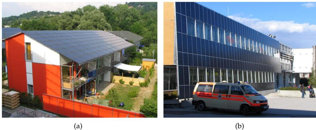
FIGURE 1.9 – (a) Toit photovoltaïque sur un logement dans l'écoquartier Vauban à Fribourg-en-Brigau en Allemagne. (b) Double-façade photovoltaïque en partie vitrée sur le bâtiment administratif de la foire de Wels en Autriche.
