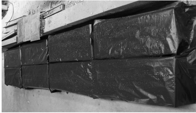
Figure 2.3 : Moule métallique recouvert par une bâche plastique.
